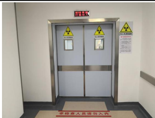
防护门外工作状态警示灯及警告标志
