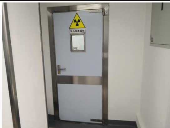
控制室防护门
