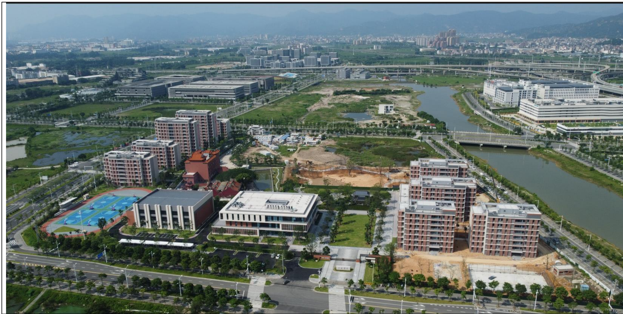
医院拟建场地南侧怀海路及阳光学院（滨海院区）
